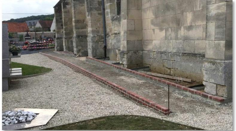
Afin de mettre en conformité l'accès de l'église aux personnes à mobilité réduite, les employés communaux ont réalisé une rampe d'accès en béton lavé.
